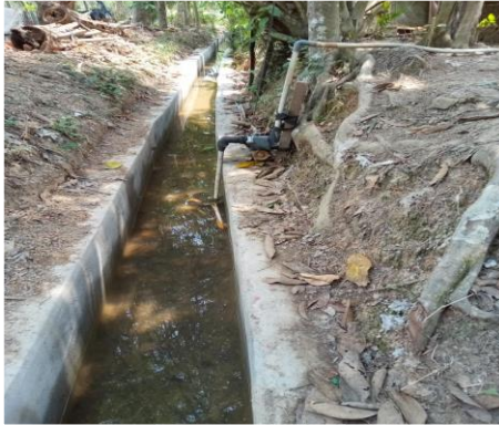
Penyadapan liar menggunakan pompa di tersier DI Komering
